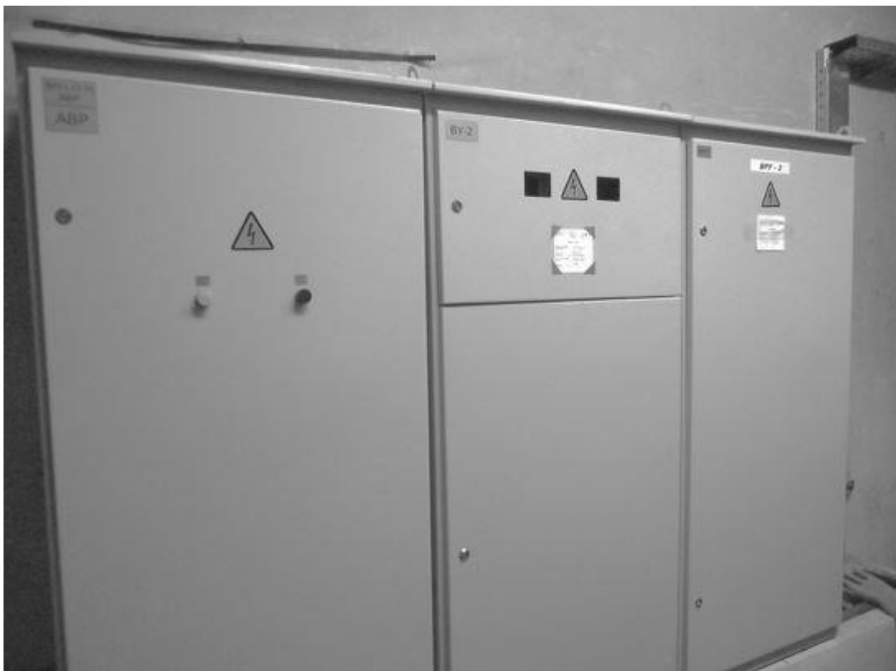
Рисунок 7 – Вводно-распределительное устройство №2
