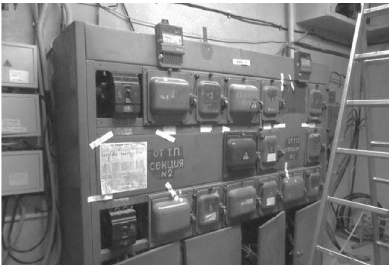
Рисунок 6 – Вводно – распределительное устройство №1
