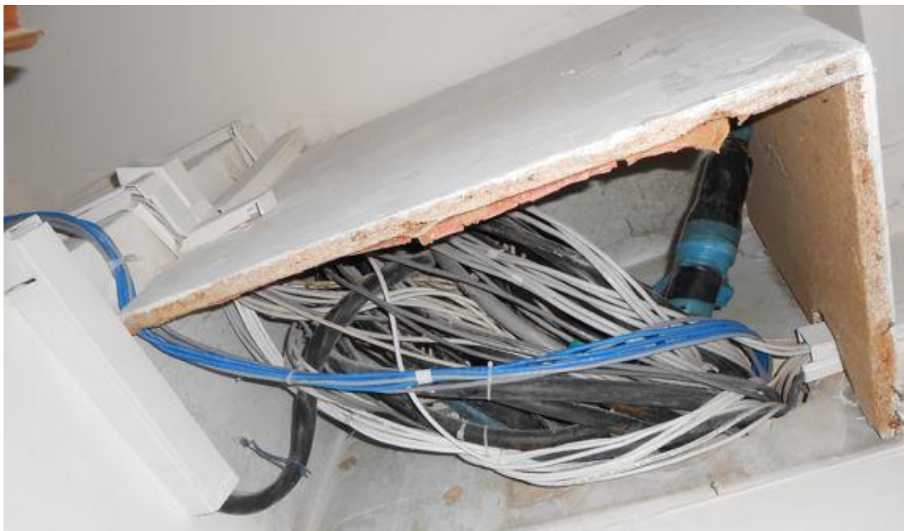
Рисунок 15– Большое количество проводов в одном лотке
