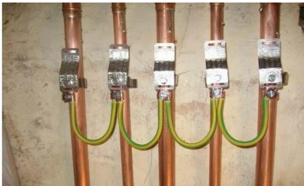
Рисунок 1 – Схема выравнивания потенциалов труб в квартире
