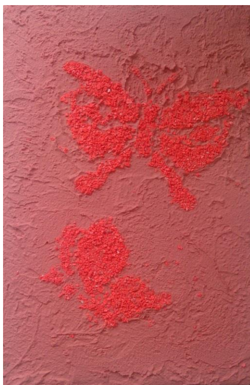
Рисунок 3.8 - Устройство финишного покрытия с применением трафаретов
