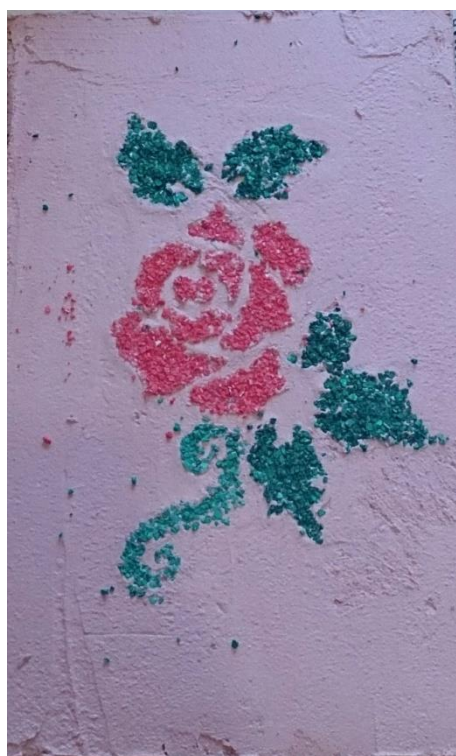
Рисунок 3.8 - Устройство финишного покрытия с применением трафаретов
