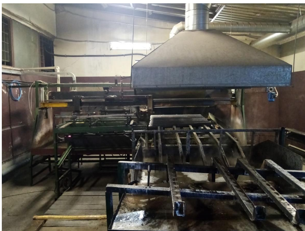
Рисунок 66 – Установка для закалки ТВЧ №3
