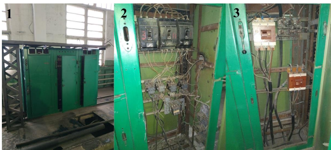
1 – вид секций внутри цеха; 2,3 – вторая и третья секции соответственно
