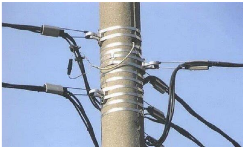
Рисунок 16 - Правильное крепление СИП на столбе
