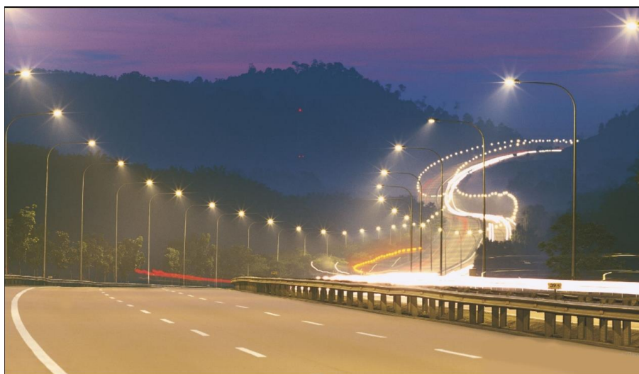
Рисунок 5 – Двусторонняя схема расположения фонарных столбов
