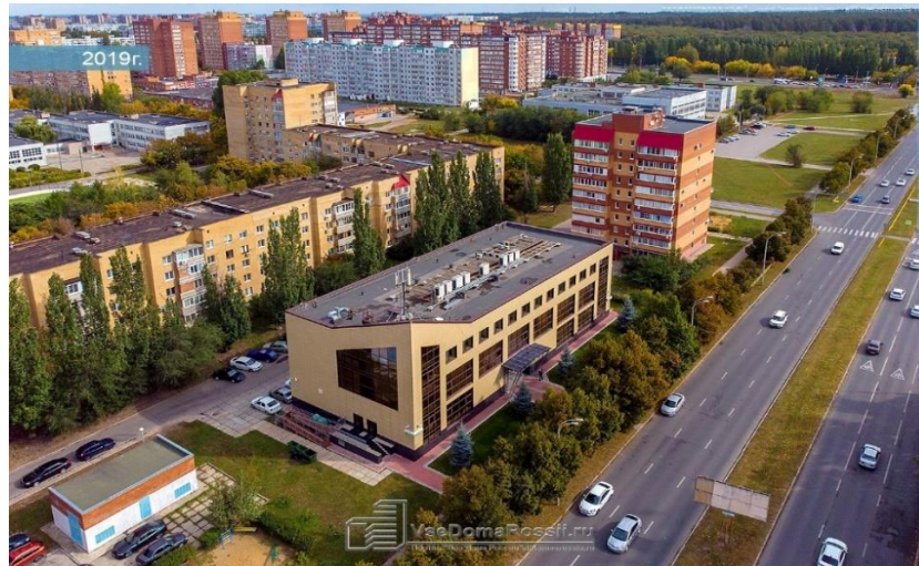
Рисунок 1.3 – Вид сверху на здание, в котором проектируется кафе
