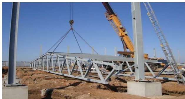
Рисунок 3.4 – Подача элементов фермы для укрупнительной сборки
