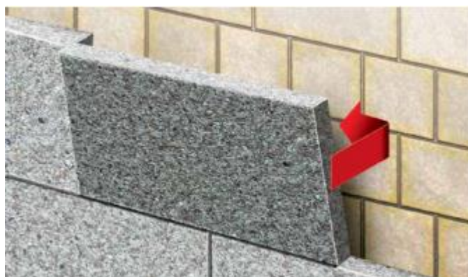
Рисунок 16 – Приклеивание плиты утеплителя
