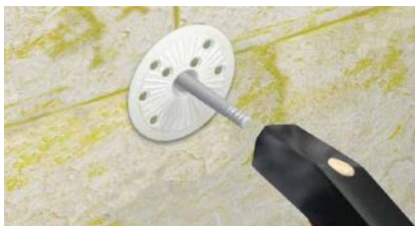
Рисунок 17 – Установка тарельчатого дюбеля
