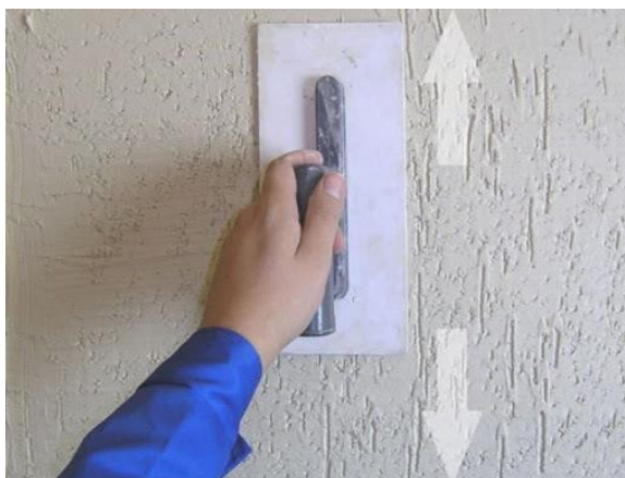
Рисунок 19 – Нанесение растворной смеси
