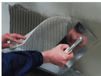
Рисунок 18 – Крепление армирующей сетки к утеплителю
