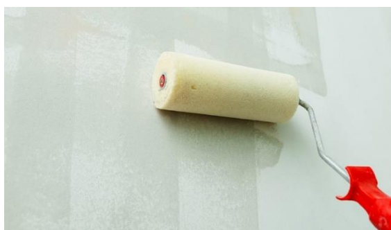
Рисунок 3.1 – Грунтование поверхности
