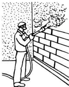
Рисунок 3.1 - Механизированное нанесение слоя обрызга с помощью растворонасоса
