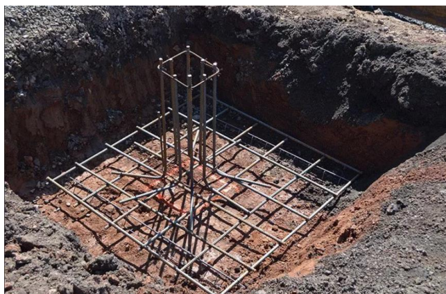
Рисунок 3.2 – Вариант установки арматурной сетки
