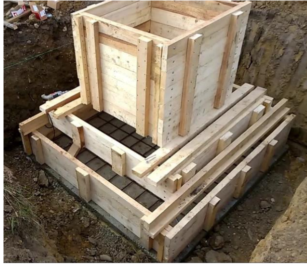
Рисунок 3.3– Вариант установки опалубки и арматурной сетки в проектное положение
