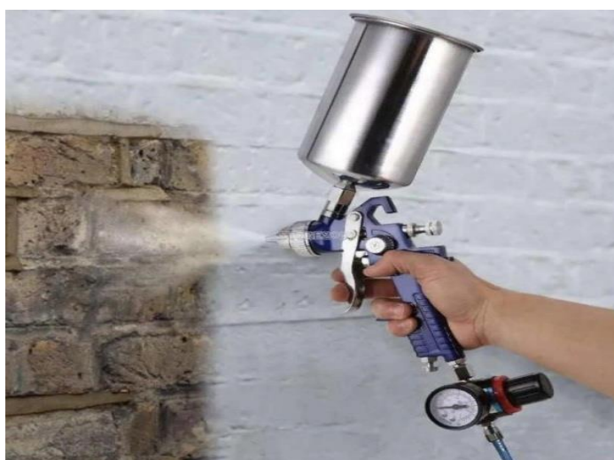
Рисунок 3.3– Окрашивание стен краскопультом
