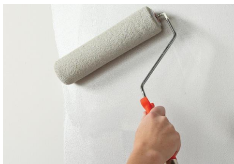
Рисунок 3.1 - Грунтование очищенной поверхности
