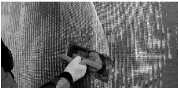
Рисунок 3.13 – Устройство базового штукатурного слоя, армированного стекло-сеткой
