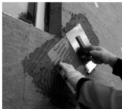
Рисунок 3.11 – Установка усиливающих элементов
