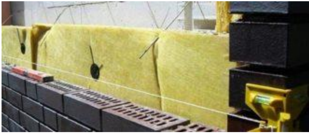
Рисунок 3.2 – Кладка наружной стены
