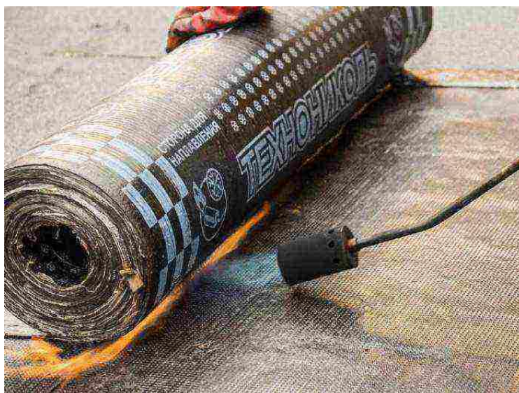
Рисунок 3.3 – Технология наплавления рулона
