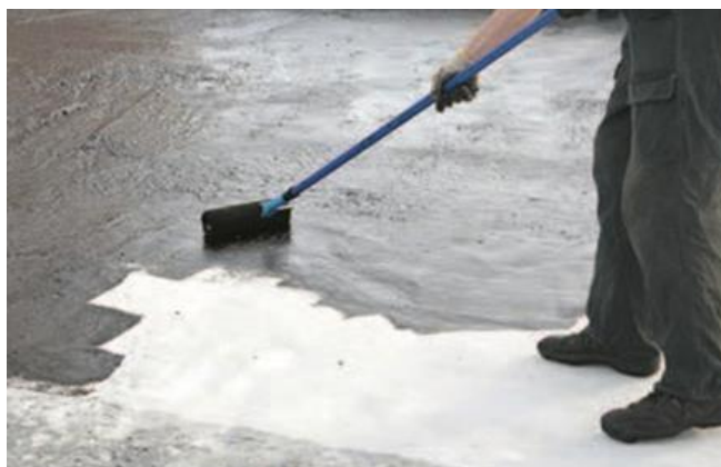
Рисунок 3.1 – Нанесение праймера малярным валиком
