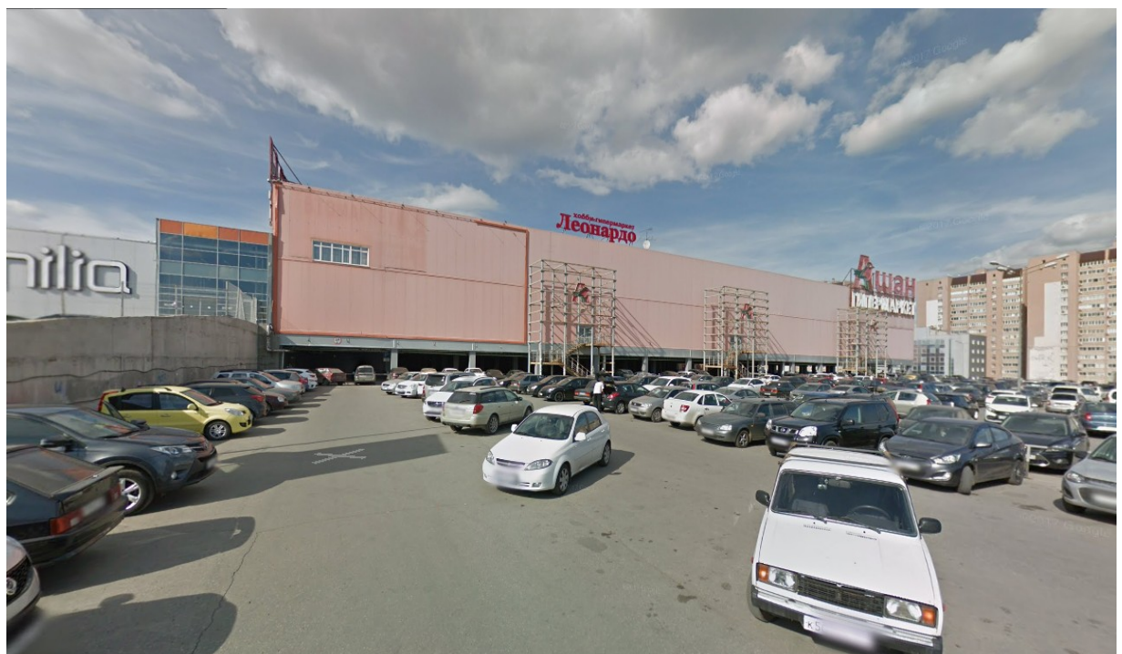
Рисунок 6 – Часть здания ТК «Космопорт» со стороны гипермаркета «Ашан»
