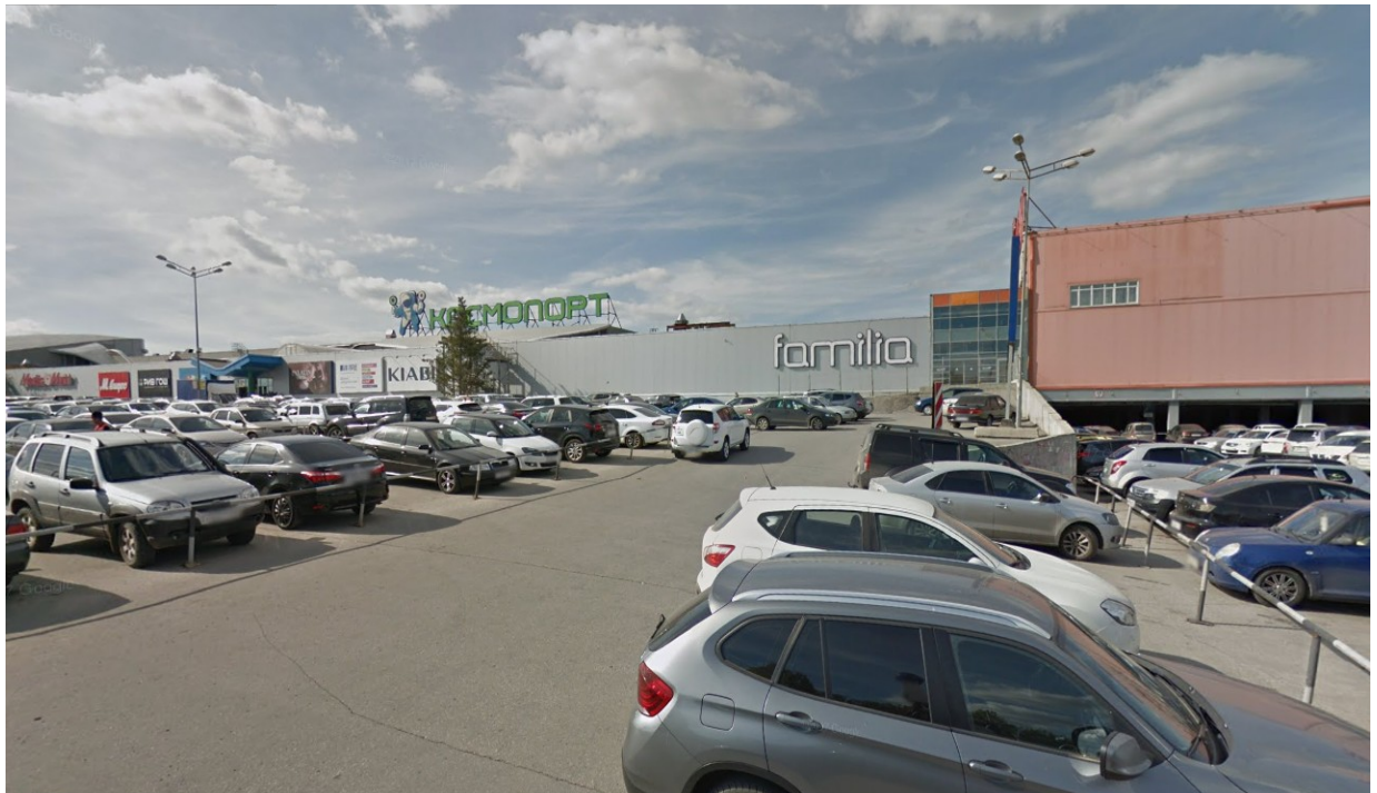
Рисунок 5 – Фасадная часть здания со стороны гипермаркета «Ашан»
