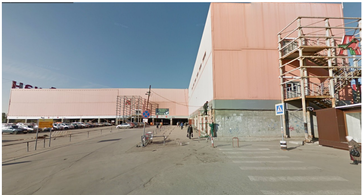
Рисунок 8 – Торцевая часть здания ТК «Космопорт» со стороны гипермаркета «Ашан»
