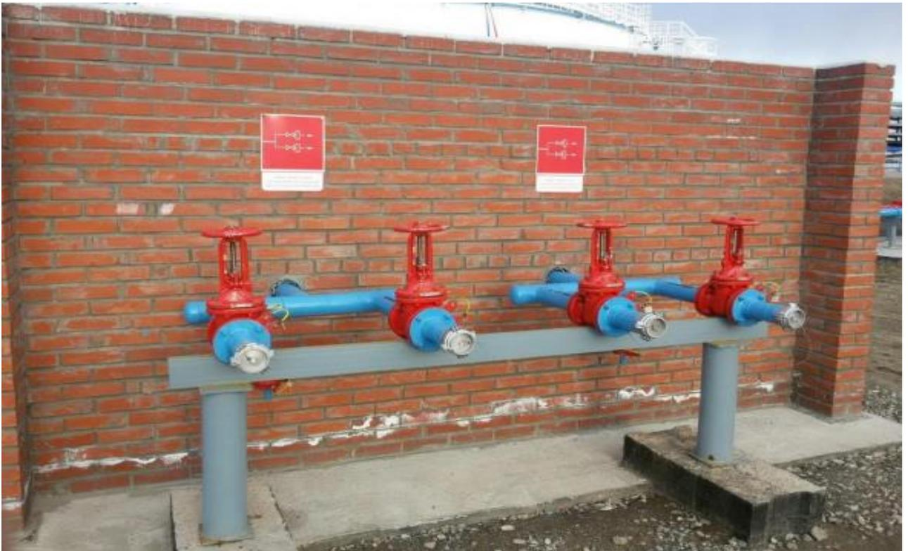
Рисунок 2.4 – Узел подключения водяного охлаждения
