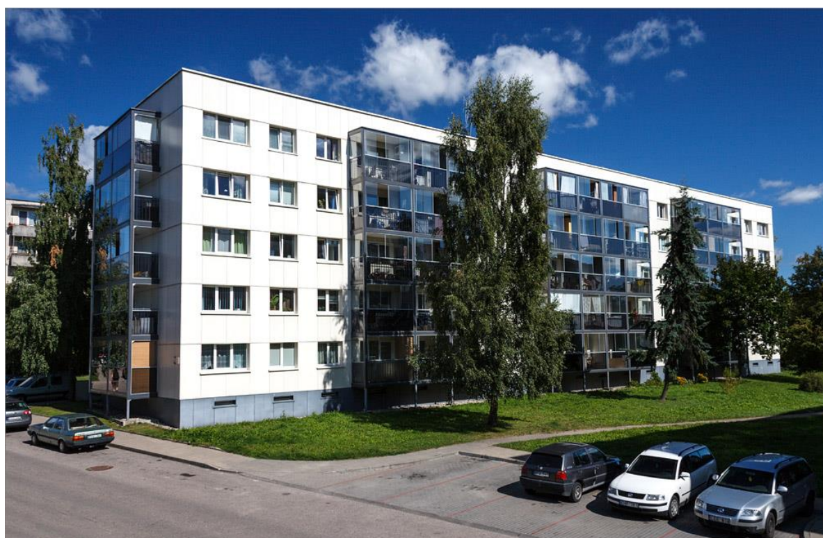
Рисунок Д.6 – Реконструкция пятиэтажного панельного дома в Санкт-Петербурге
