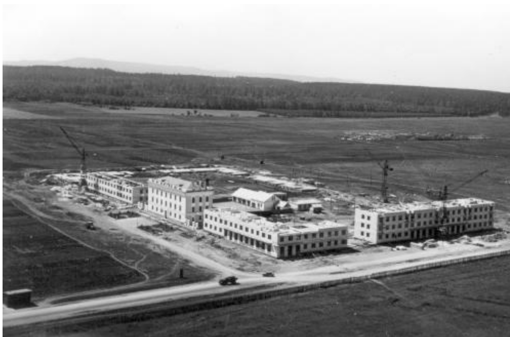
Рисунок 1.17 – Начало строительства улицы Мира
