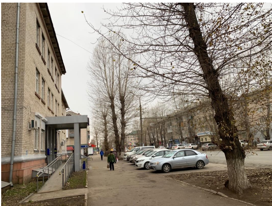
Рисунок 1.10 – Территория, прилегающая к зданию главного отделения почты по Центральному району (участок с пересечением (ул. Жилина – ул. Победы)
