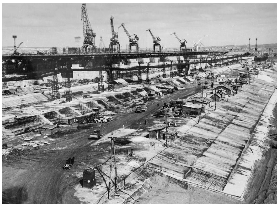
Рисунок 1.16 – Строительство Куйбышевской ГЭС
