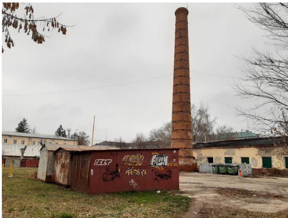
Рисунок 6 – котельная с трубой
