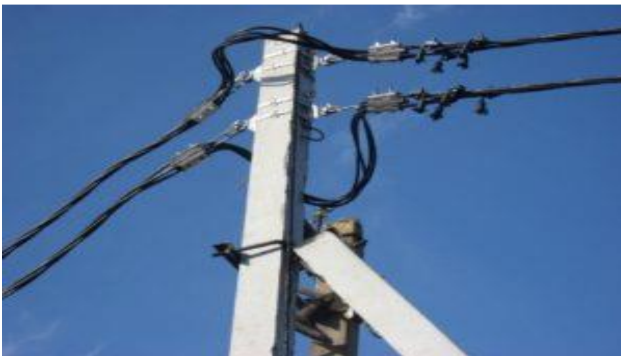
Рисунок 4 - Пример монтажа провода СИП на опоре
