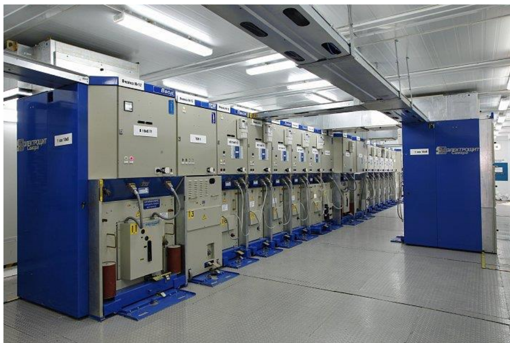
Рисунок 14 – Общий вид шкафов серии К-61М и К-63
