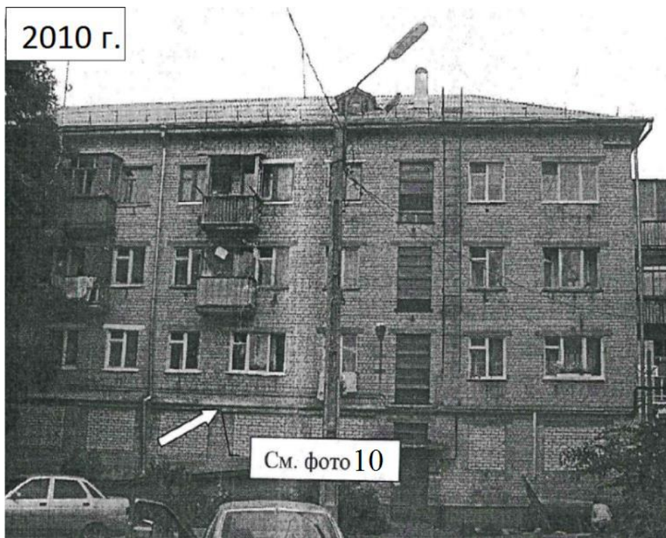
Рисунок 9 - Фасад жилого дома с магазином на первом этаже со стороны двора (восточная часть здания)
