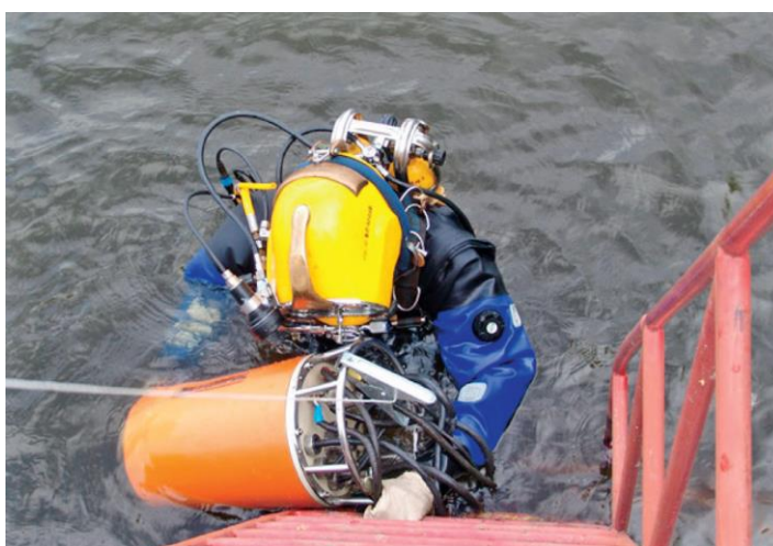
Рисунок 1.1 – Спуск водолаза-сварщика для проведения подводной ремонтной сварки
