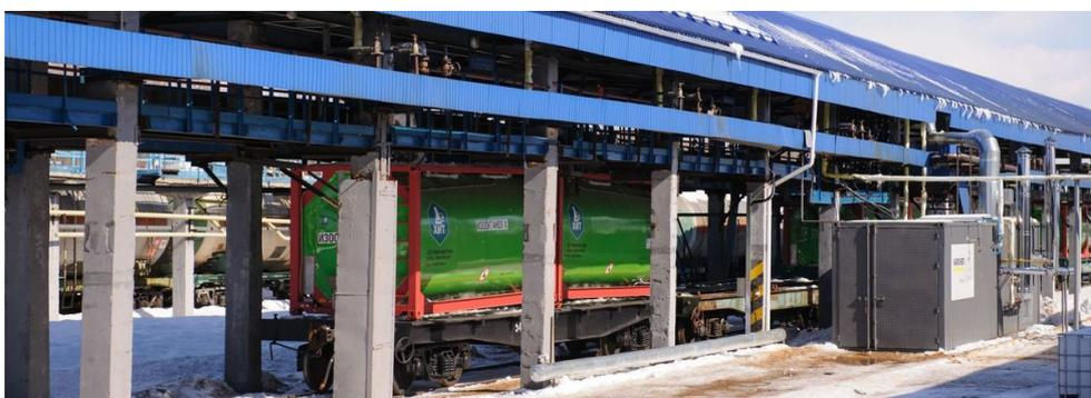
Рисунок 4.1 – Уличный моечный комплекс для промывки-пропарки цистерн
