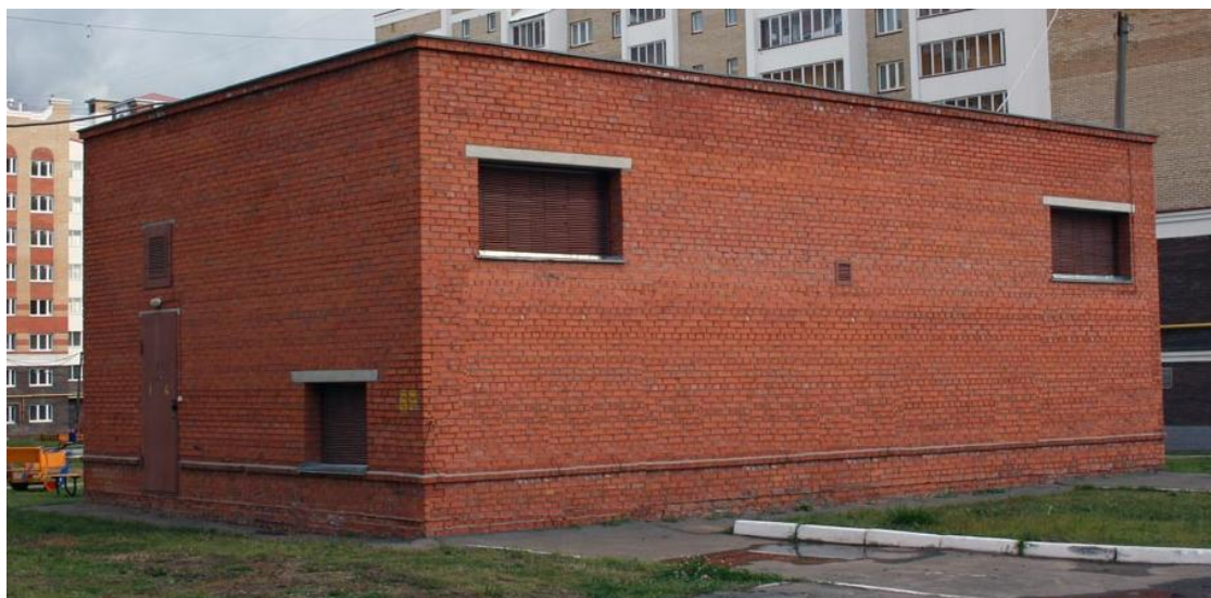
Рисунок 1 – Капитальное строение РП 6 кВ
