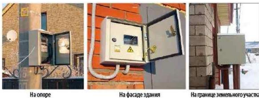
Рисунок 4 - Варианты монтажа выносных щитов учета электроэнергии
