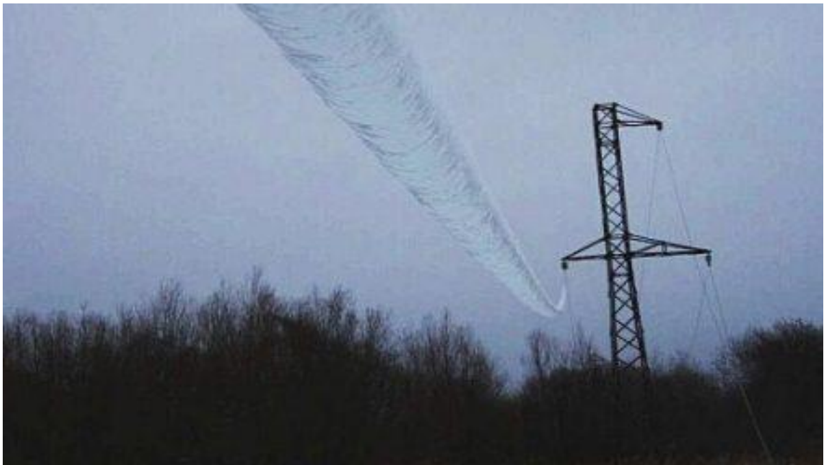
Рисунок 2 – Толщина стенок гололедных образований на ВЛ
