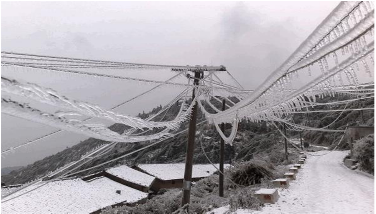
Рисунок 1 – Лавинообразный процесс образования ледяной корки
