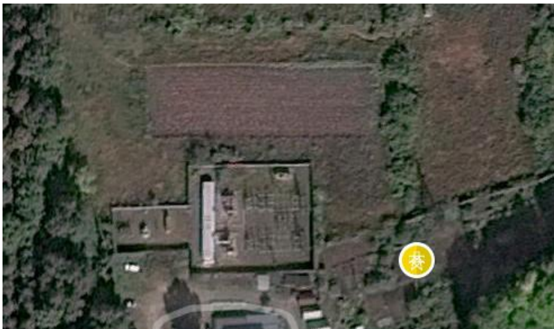
Рисунок 1.1 – План расположения подстанции «Веселовка» 110/10 кВ
