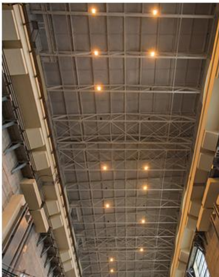
Рисунок 1.6 – Потолочное освещение машинного зала
