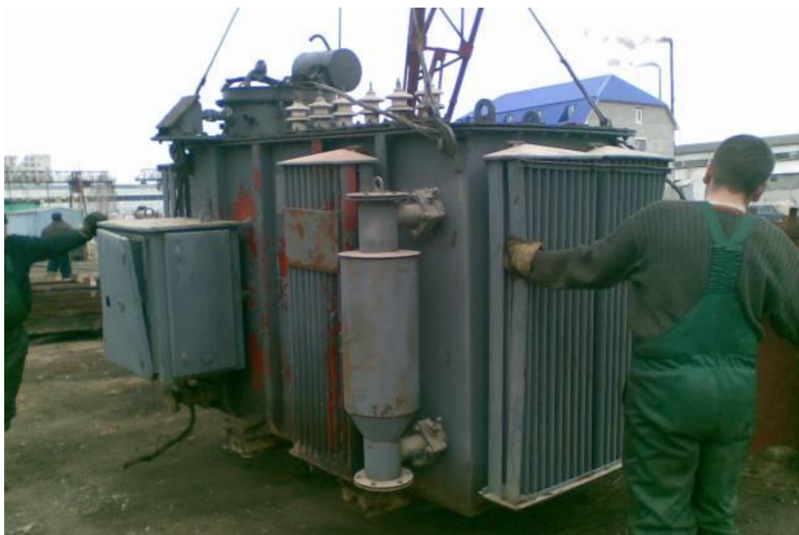
Рисунок 1.1 – Подготовка трансформатора марки ТНЗП к утилизации
