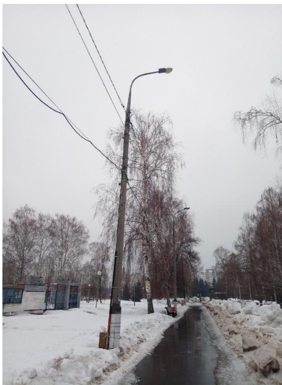
Рисунок 4 – Аллея, освещаемая светильниками ЖКУ 21-100-001
