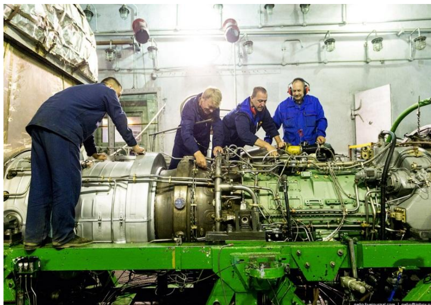
Рисунок 1.4 - Монтаж двигателя НК-16СТ в испытательном боксе.
