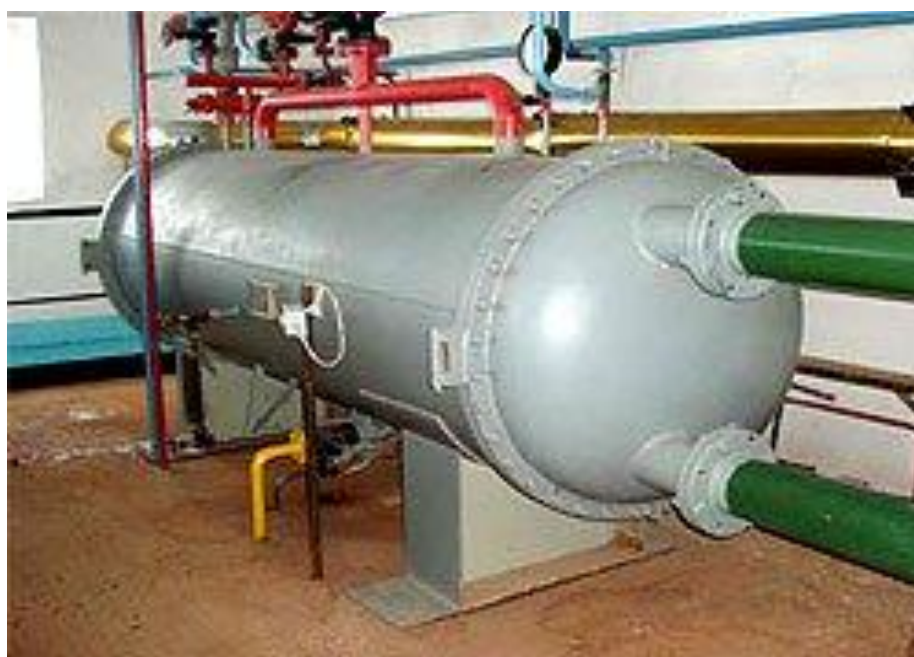
Рисунок 6 – Аммиачный конденсатор КТГ
