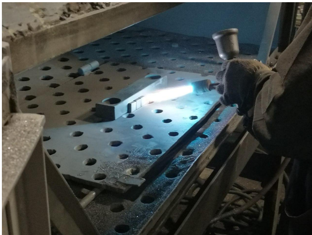
Рисунок 5.1 – Процесс нанесения покрытия
