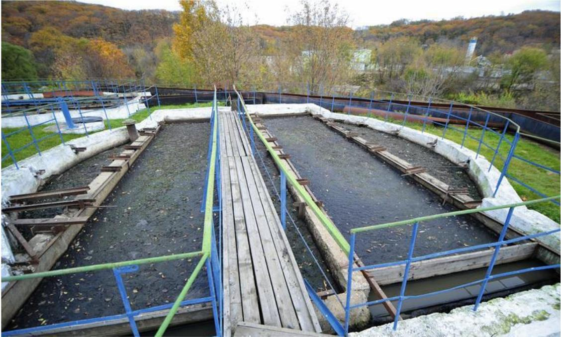
Рисунок 7 – Иловая площадка очистных сооружений
