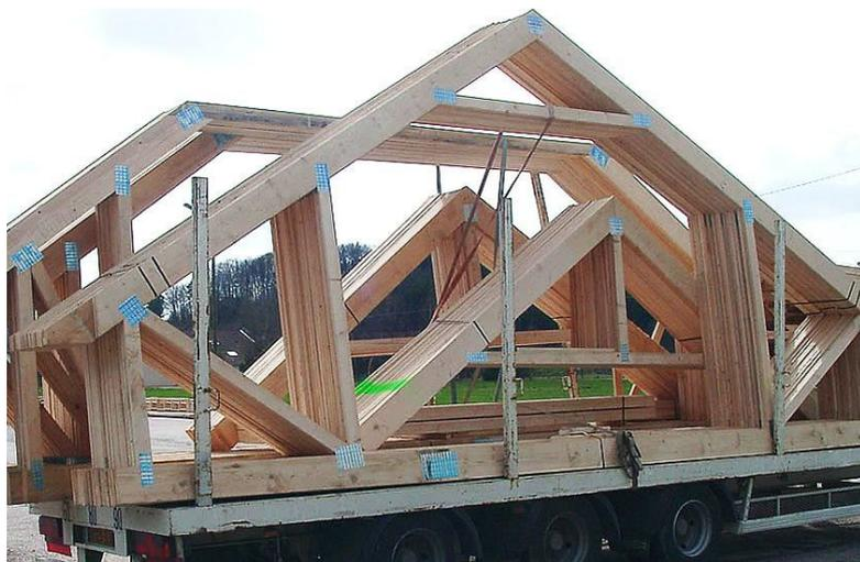
Рис. 3. Транспортировка фермы деревянной
