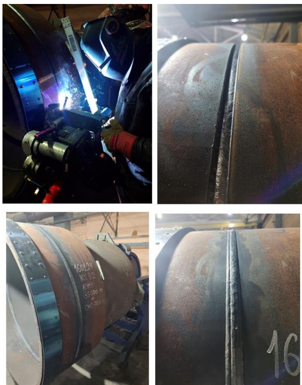
Рисунок 43 – Процесс сварки КСС с применением комбинированной технологии сварки МП+МПИ
