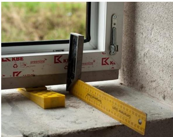
Рисунок 6 – Установка временных подкладок
