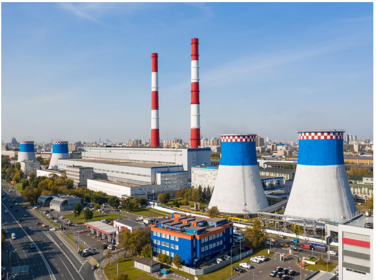
Рисунок 1 – Современная электростанция типа ТЭЦ
