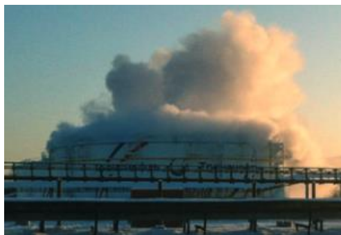
Рисунок 2 – Выпуск \text{CO}_2 на РВС-20000
