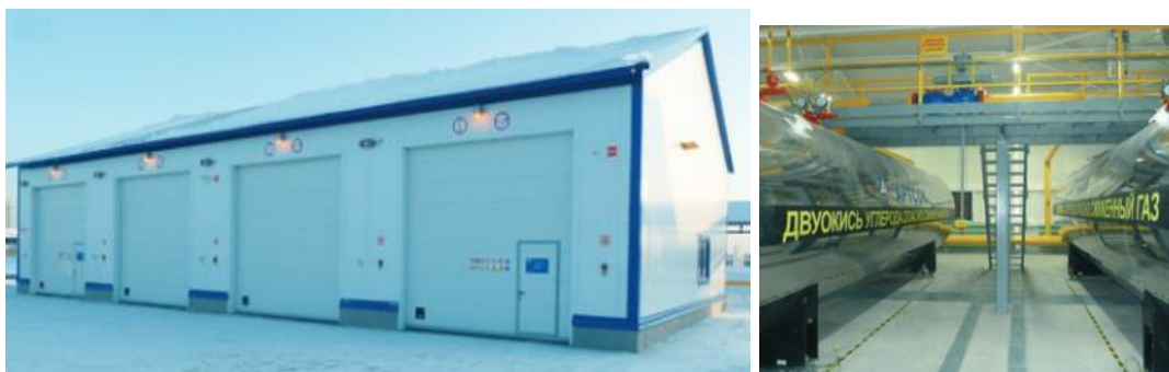
Рисунок 1 – Здание станции газового пожаротушения
