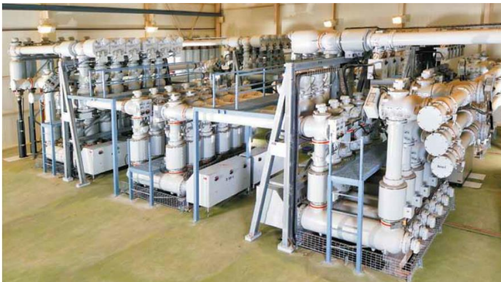
Рисунок 5 – Внешний вид и компоновка выбранного типа КРУЭ-220 кВ с ячейками ABB ELK-14
