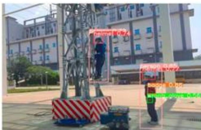
Рисунок 6 – Пример того, как технологии YOLOv8 на MobileOne-S0 обнаруживает нарушения
