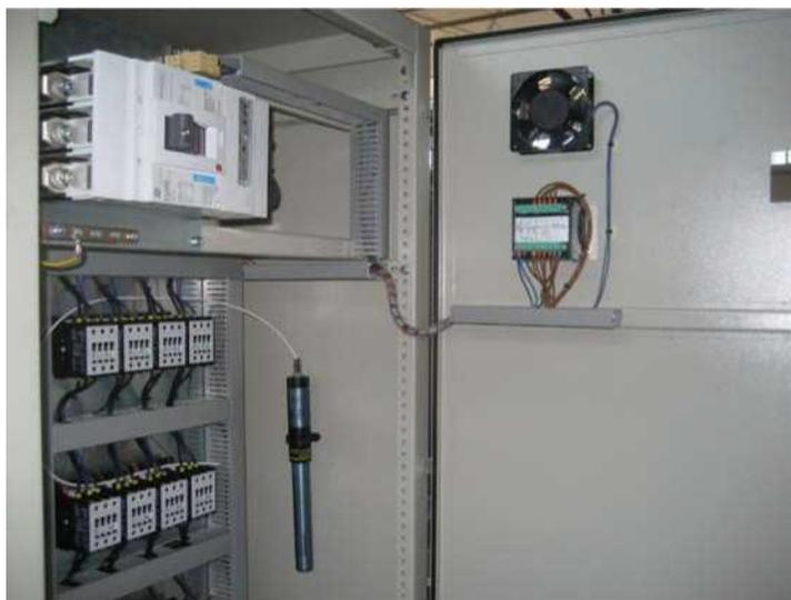
Рисунок 1 – Место установки устройства пожаротушения аэрозолем
