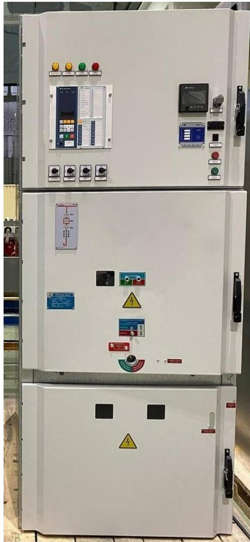
Рисунок 5 – «Конструктивное выполнение ячейки КРУ-ZETO-10 (ЗАО «ЗЭТО»)» [7]
