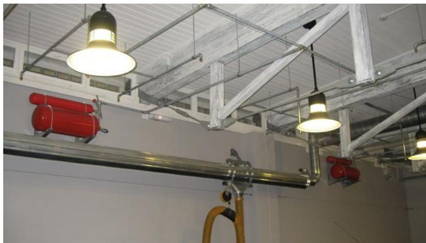
Рисунок 12 – Модульная установка тушения пожара тонкораспылённой водой - МУПТВ с вертикальным пусковым баллоном
