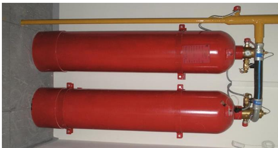
Рисунок 15 – Схема технологической части установки газового пожаротушения
