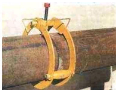
Рисунок 5 – Сборка труб с применением эксцентрикового центратора
