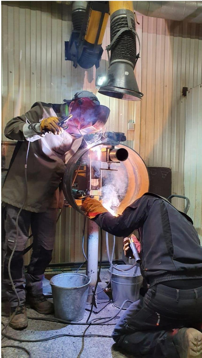
Рисунок 36 – Выполнение заполняющего слоя шва «на спуск» и «на подъем»
