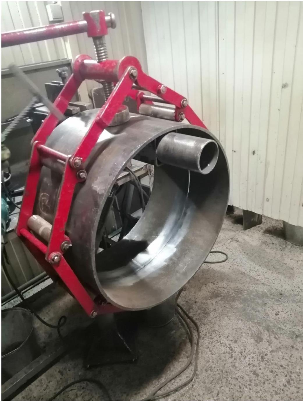
Рисунок 32 – Собранный стык с применением наружного центратора
