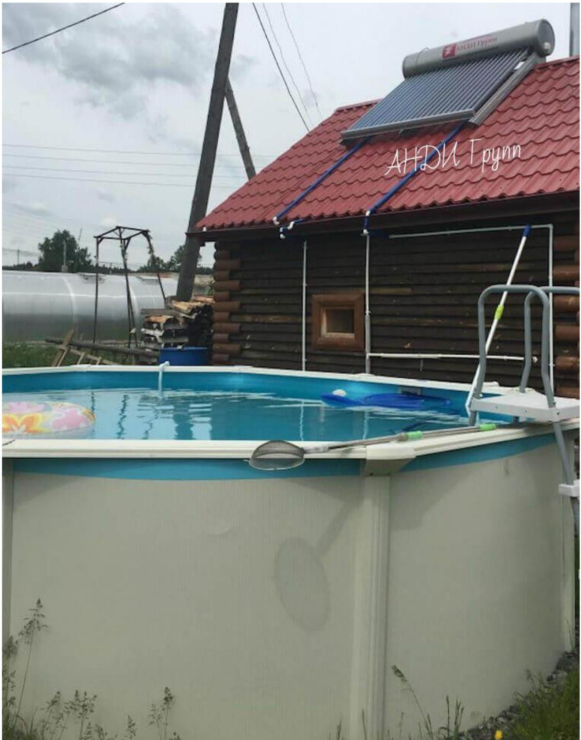
Рисунок 11 – Установка солнечного коллектора на кровлю бани
