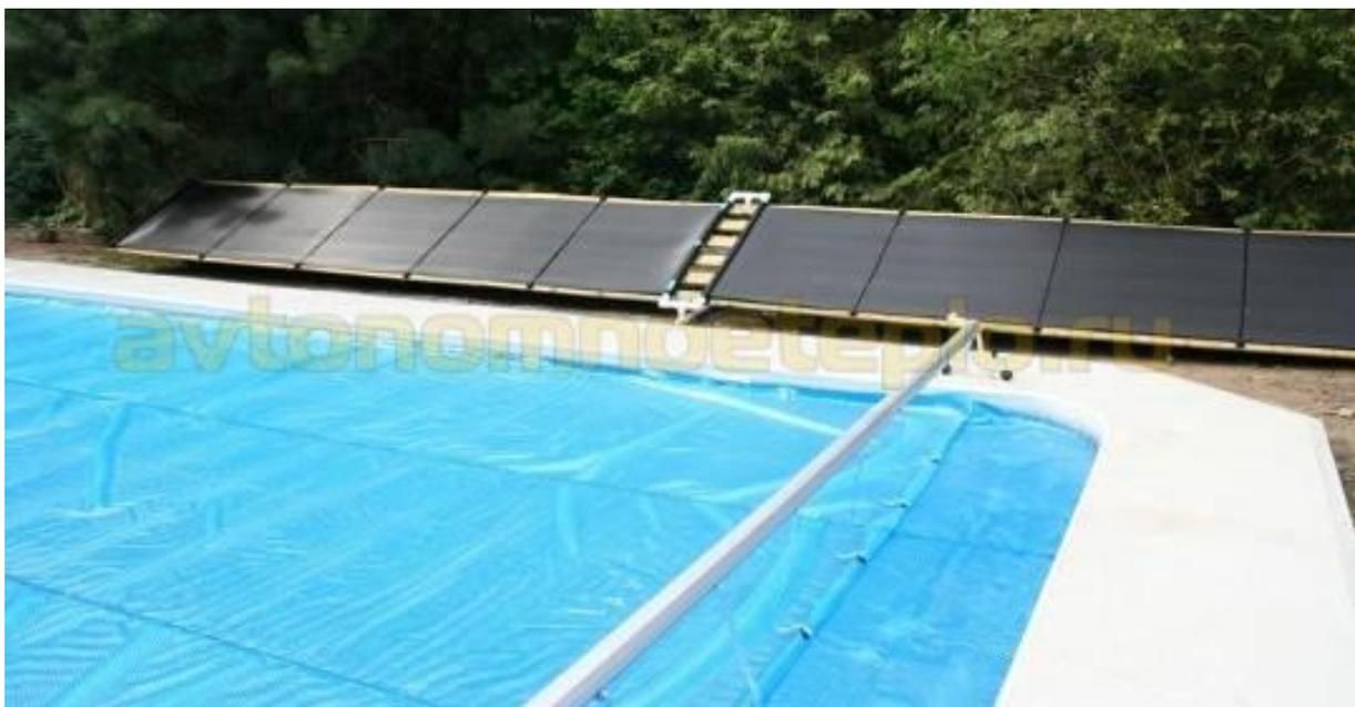
Рисунок 26 – Пример расположения гибкого коллектора (абсорбер)
