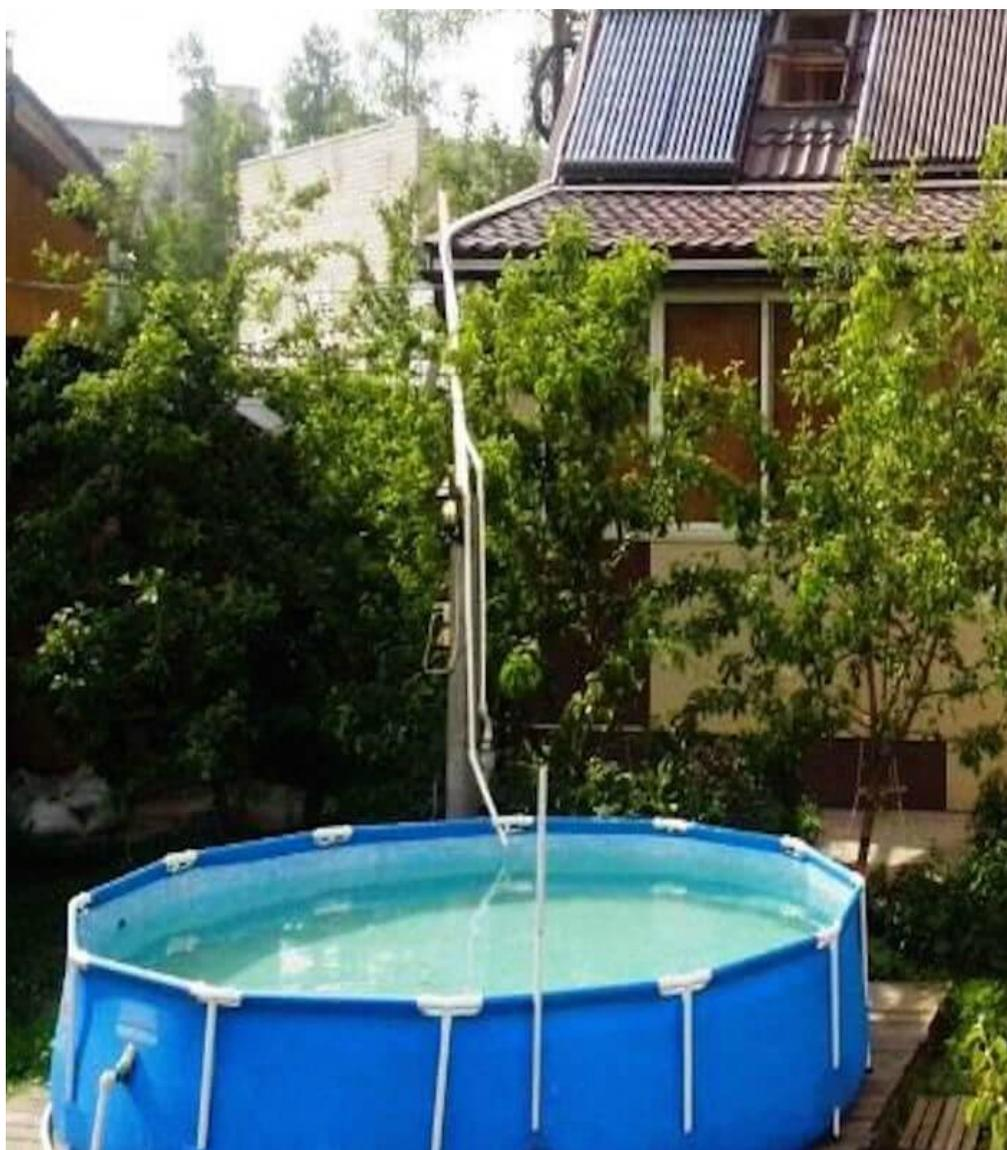
Рисунок 10 – Установка коллектора для теплоснабжения сезонных бассейнов на конструкцию кровли здания
