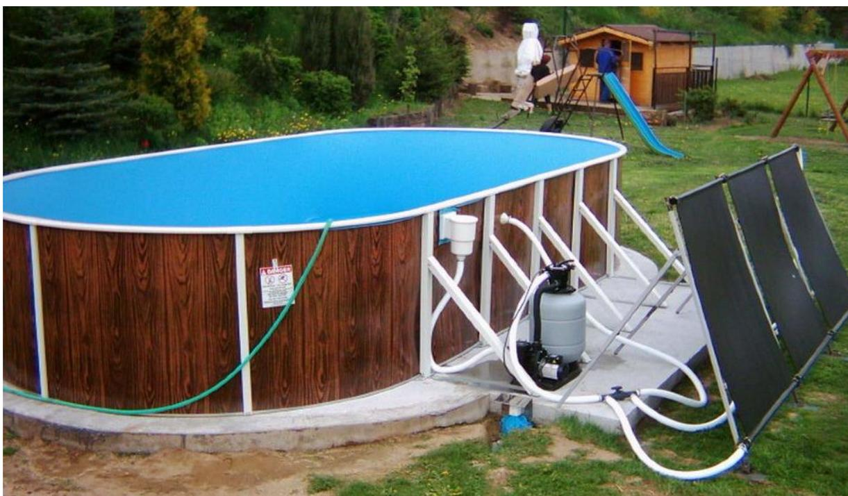
Рисунок 25 – Солнечный гибкий коллектор (абсорбер) Azuro
