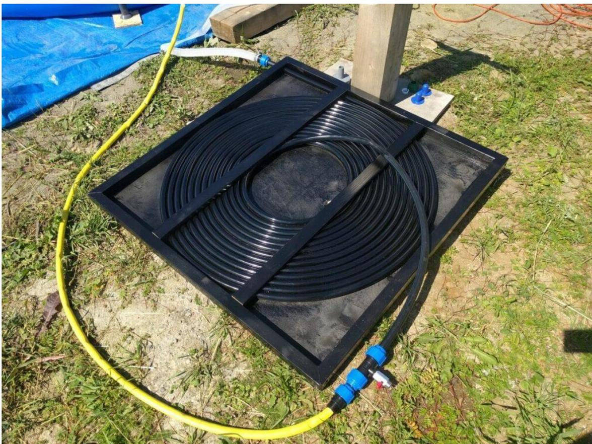
Рисунок 20 – Пример самодельного плоского солнечного абсорбера для бассейна
